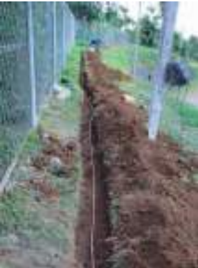
Nueva red de bajantes eléctricas con conexión a malla de tierra.
